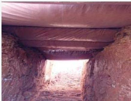
Cubierta de refugio (Foto:REI N° 11)
