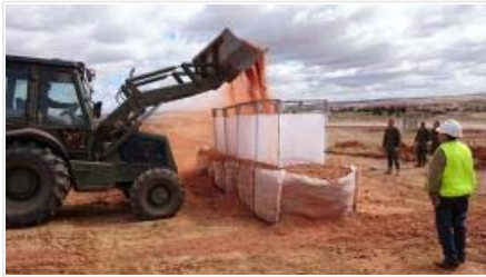
Módulo de 1 metro de ancho a doble altura (Foto:REI N° 11)
